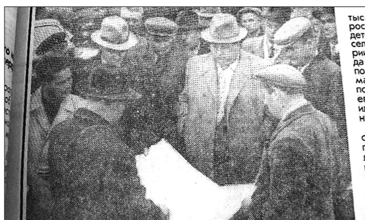
Василий Комяхов (в центре) на строительстве водохранилища.
